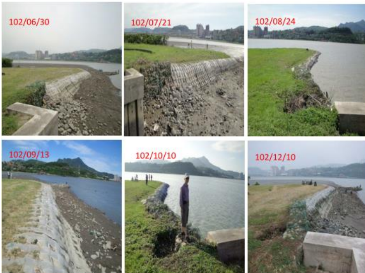
圖 6 社子島頭土工沙腸護岸局部沖刷情形
