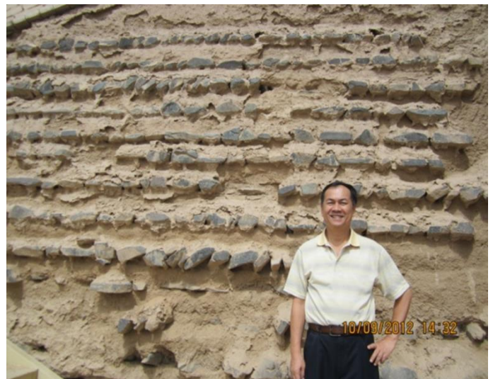
圖 5: 懸臂長城位於嘉峪關城北 8 公里北側的黑山，以黑色之岩片夾入黃土中加以夯實，成為加勁擋土牆
