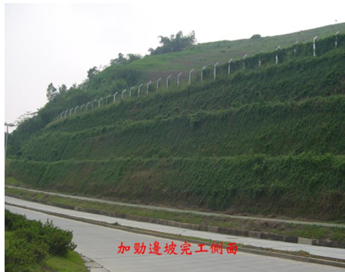
圖 7. 暨南大學邊坡於九二一地震後重建，採用回包式加勁擋土牆
