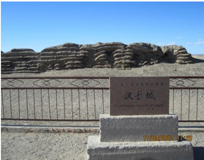
圖 2. 玉門關的漢長城-古代的加勁土壤結構
