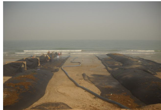
圖 10 地工沙腸袋堤心施作過程
