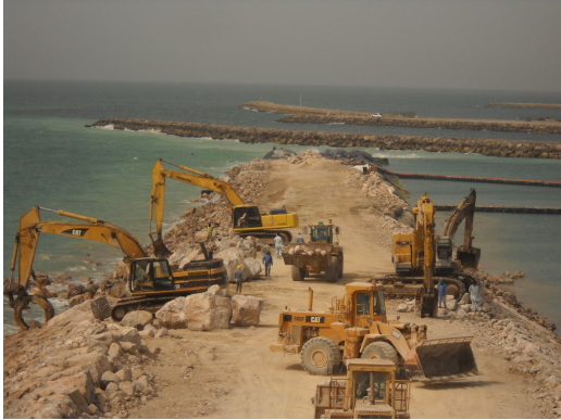
圖 11 外覆拋石施作過程
