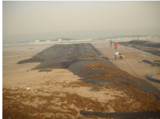
圖 7 地工沙腸袋鋪設過程
