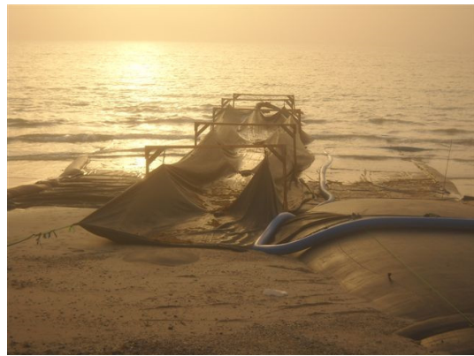
圖 8 地工沙腸袋輔助固定設施
