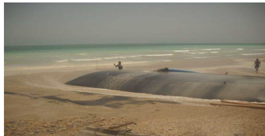
圖 9 地工沙腸袋灌注過程
