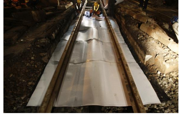
圖 18. 土工排水板鋪設
