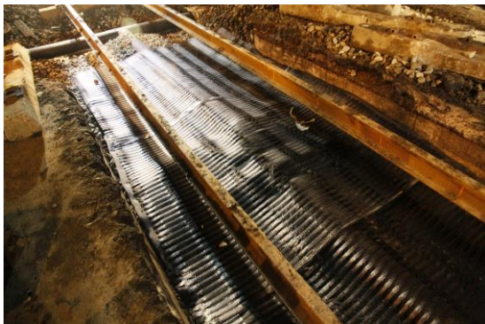
圖 16. 土工格網鋪設
