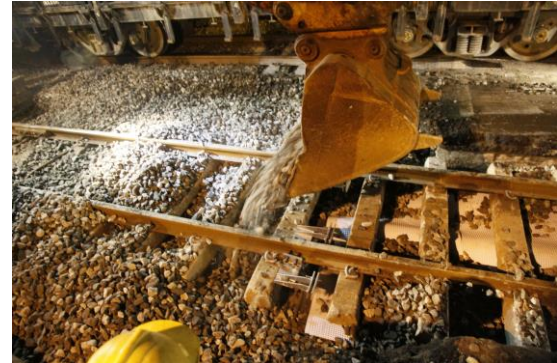
圖 20. 新鮮道碴回填至設計高度
