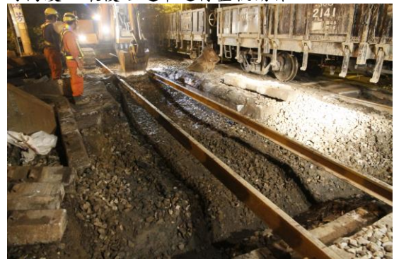
圖 13. 開挖至施工深度
