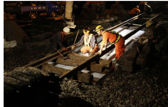
圖 19. 土工材料配置完成軌枕安裝
