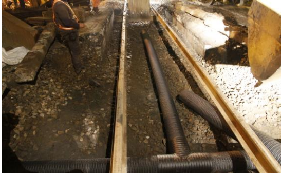
圖 14. 配置排水網管及固定
