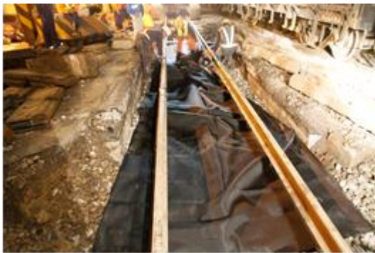
圖 15. 土工織布鋪設
