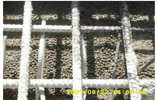
圖 2 國六採用淤泥燒製的混凝土骨材，強度不差（取材自中興顧問公司）
