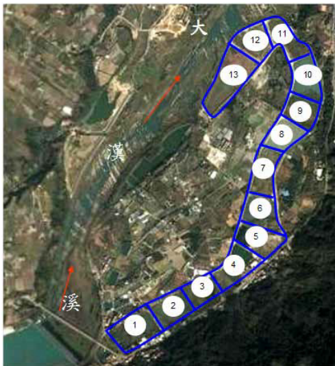
圖 1 石門水庫的 13 座沈澱池
