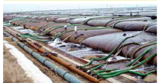
圖 6 天津採用砂腸袋儲淤泥果案例 (b) 施工（取材自 Tencate Company）
