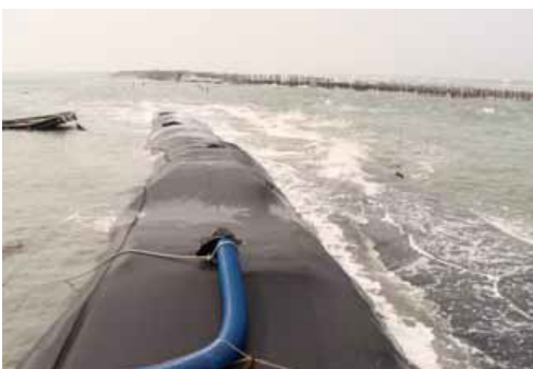
圖 5 砂腸袋內儲存淤泥，體積龐大，可填海造陸或做為海事工程材料（取材自盟鑫工業公司）
